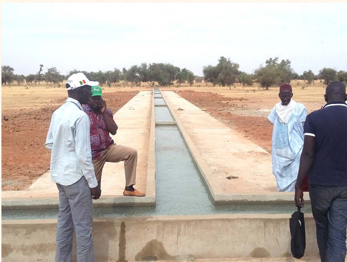
Les nouveaux abreuvoirs en forme de « T » avec des dalles anti-bourbiers construites par le PADAER
